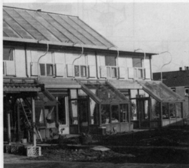
Achterzijde zonnepouwwoning Leiderdorp
