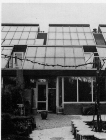
Proefopstelling collectoren TNO Zuidpolder (Delft)
