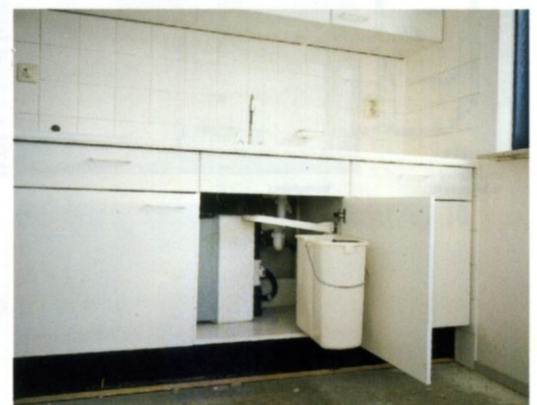
Scheiden huisafval: Duo-afvalbakken voor het gescheiden inzamelen van gft en ander huishoudelijk afval zijn standaard aangebracht in een gootsteenkastje bij alle woningen.
