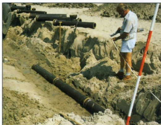
Buitenriolering: Herbruikbaar gres verbindt de woningen met het hoofdriool, in plaats van PVC-buizen.
