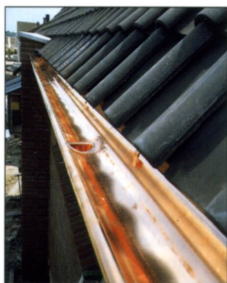
Hoewel extreem duurzaam, is koper voor goten en regenwaterafvoer slechts aan de straatzijde van één woningproject aangebracht, vanwege de hoge kosten.
