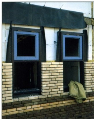
Kozijnslabbe: Aanvankelijk was het de bedoeling EPDM als kozijnslabbe te gebruiken. Dit materiaal bleek te slap bij toepassing in de eerste woningen. Er is daarom gekozen voor DPC-folie als kozijnslabbe voor de andere woningen.
