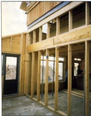
Houtskeletbouw: De houtskeletbouw-woningen van BEAR en Moehrlein zijn op de bouwplaats geassembleerd uit geprefabriceerde grote bouwdelen. Aannemer Wilma Bouw gebruikte veel van de eigen kennis in de detaillering van de woningen.
