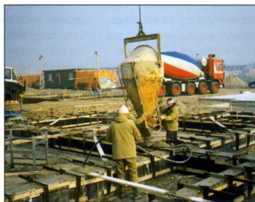
Funderingsbalken: Ook bij in het werk gestort beton is betonpuingranulaat als grindvervanger toegepast. Niet iedere betoncentrale verwerkt deze grondstof. Bovendien treden door gebrek aan puingranulaat soms langere levertijden op.
