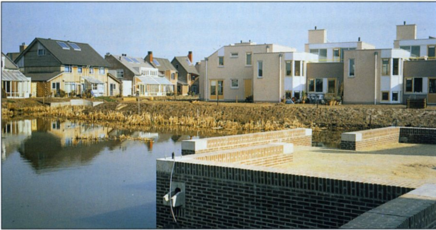
Ontmoetingsplaats: De harde en deels uitspringende kademuur van de waterpartij, een centraal gelegen kruispunt voor sociale functies in de wijk.
