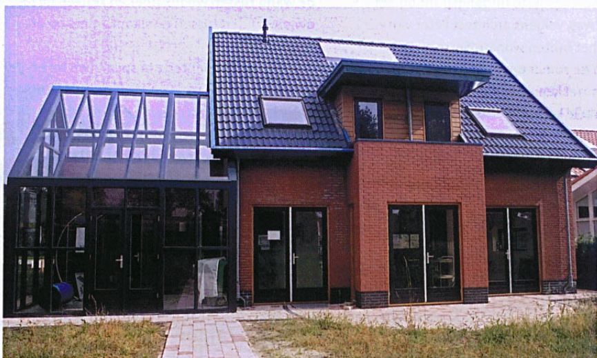
Concept met serre De zuidgevel is zeer open met vier dubbele openslaande deuren op de begane grond. De serre is uitgevoerd in enkel glas en speelt een rol bij de voorverwarming van (een deel van) de ventilatielucht. Met name dit laatste aspect speelde een belangrijke rol in de jurybeoordeling van het ontwerp.
