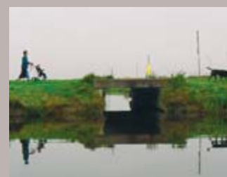
Geringe doorvaarthoogte vaste bruggen zoals onder Kalkovensweg
