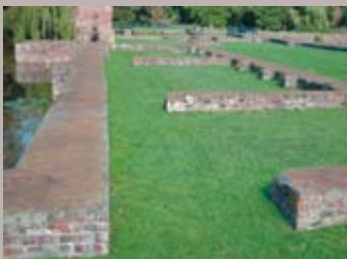
Muurwerk van kasteel Egmond
