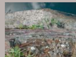
Gereconstrueerde rondeelmuur op betonnen funderingsplaat
