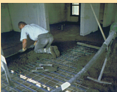
Leggen anhydriet dekvloeren
