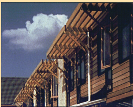
Centrale stofzuiginstallatie Zonneluifels aan de zuidgevel
