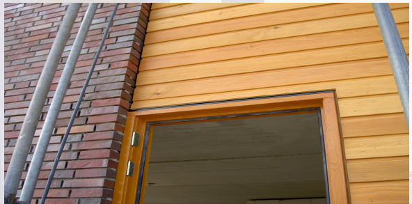
Overgang van baksteen muur --> HSB
